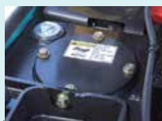
Serbatoio dell'olio idraulico
