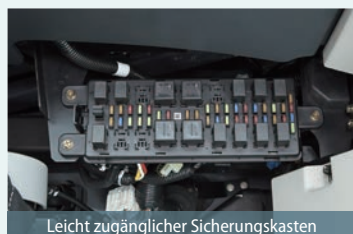
Leicht zugänglicher Sicherungskasten
