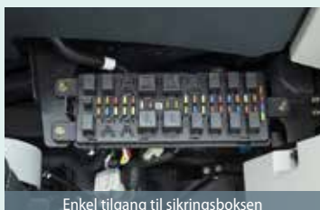
Enkel tilgang til sikringsboksen
