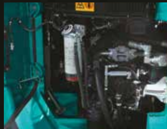
Wartung vom Boden aus
