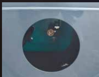
Válvula remota de drenaje del depósito de combustible
