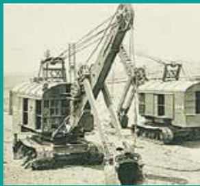
Primera pala excavadora eléctrica japonesa en 1930
