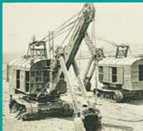
Primera pala excavadora eléctrica japonesa en 1930
