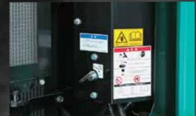
**Dispositivo de desconexión de la batería**
